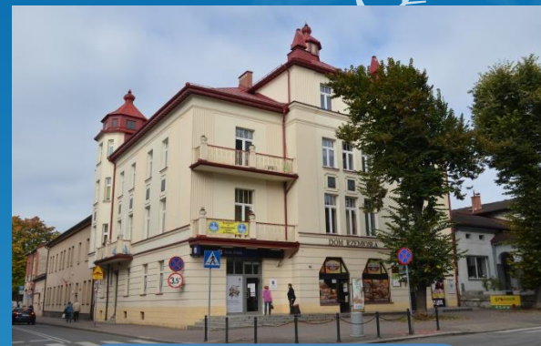
Dom Rzemiosła Przy ul. Grunwaldzkiej
